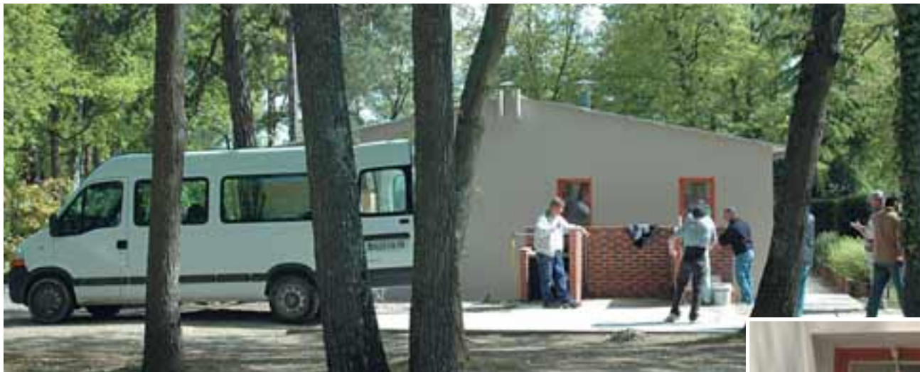
Intervention de l'équipe dans le camping municipal de Malesherbes, afin d'en repeindre les bâtiments communautaires.
